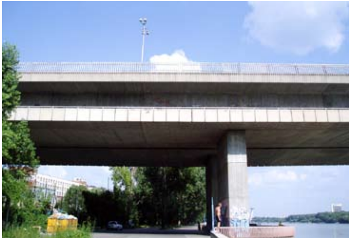
Na moście Lafranconi ciąg pieszo-rowerowy znajduje się ok. 4 m poniżej jezdni, na poziomie dolnego pasa belki mostowej (AB)
