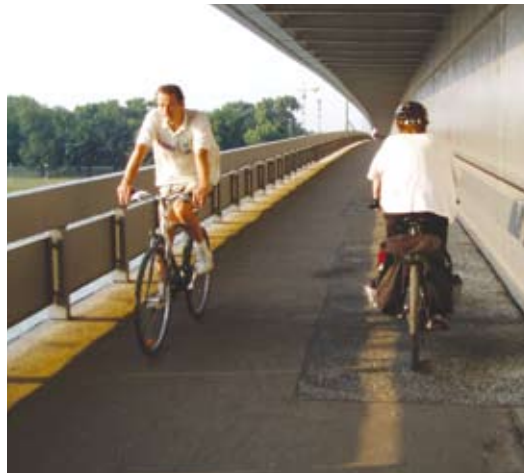
Analogiczne rozwiązanie zastosowano na Nowym Moście, pod oboma jezdniami - teoretycznie jeden z ciągów przeznaczony jest dla pieszych, drugi dla rowerzystów. Zdjęcie przedstawia ciąg południowy (AB)
