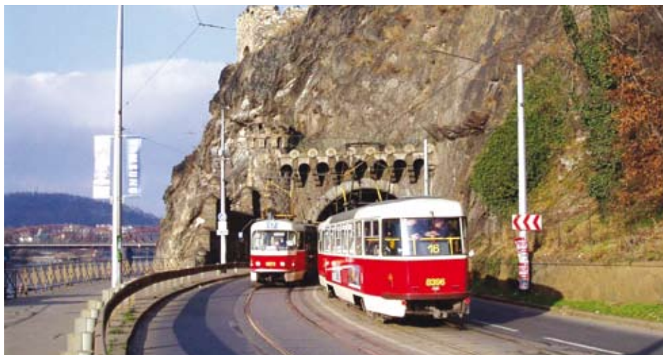
W zabytkowym tunelu pod Wyszehradem jezdnia zwęża się do jednego pasa, ale dzięki inteligentnej sygnalizacji tramwaj nie jest blokowany przez samochody (AB)
