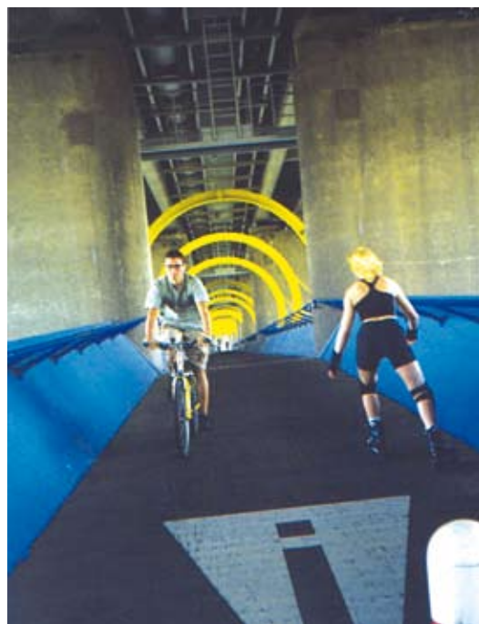
To również most nad Dunajem, ale już dla odmiany w Wiedniu. Do istniejącego mostu - pierwotnie zaprojektowanego bez ścieżki - dowiązano pod spodem, między filarami, lekką stalowo-drewnianą konstrukcję dla rowerzystów, wrotkarzy i pieszych (AB)
