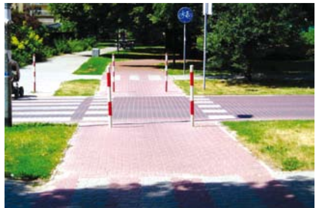
Al. Kasztanowa - przejazd dla rowerów i przejście dla pieszych przez lokalną ulicę Borsuka poprowadzone zostały grzbietem szerokiego progu płytowego, wymuszając na kierowcach zredukowanie prędkości (AB)
