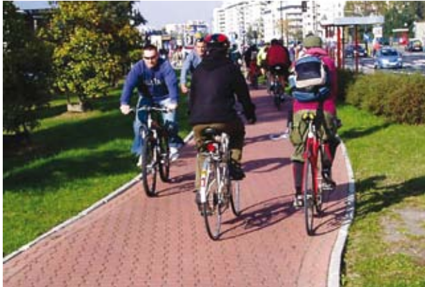
Wymagająca modernizacji ruchliwa ścieżka w al. KEN (MS)
