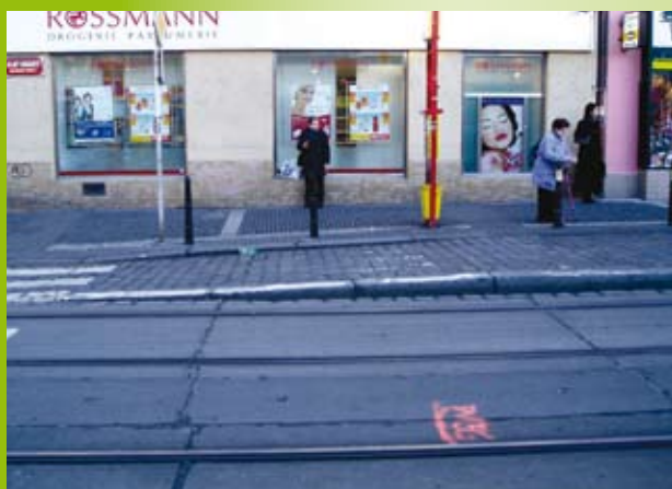
Za przystankiem prawy pas wraca do pierwotnego poziomu (AB)
