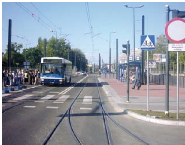
Przystanki łączone na rondzie Grzegórzeckim na pasie autobusowo-tramwajowym. (JP)
