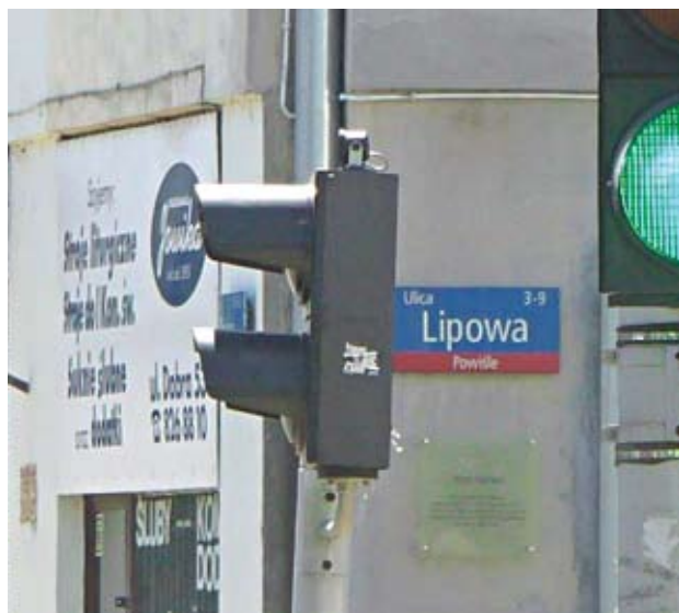
Warszawa, ul. Dobra. Przykład nadajnika stosowanego na przejściach, gdzie dla danego kierunku montowane są przyciski. Nadajnik umieszczono na komorze sygnalizatora, czyli de facto zablokowano. Daszek nad komorą sygnału czerwonego skutecznie rozprasza dźwięk i kieruje go w górę. (TR)
