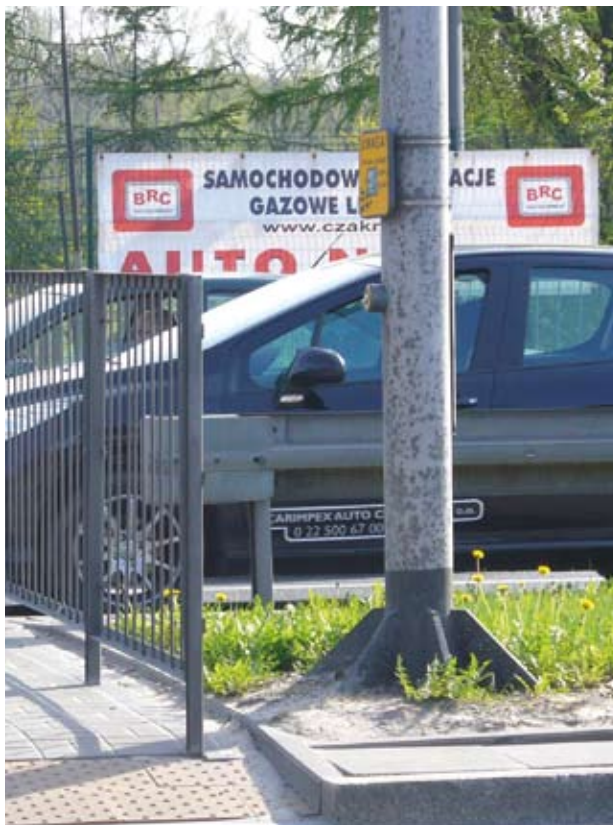
Warszawa, Wał Miedzeszyński. Wysokość: 110 cm (za nisko); przycisk po lewej stronie przejścia (przy wejściu na pas rozdzielający, zamiast przy zejściu); odgradzony od pieszego - pieszy musi okrążyć płotek, poruszając się w skrajni lub po jezdni, co potwierdzają wydeptane ślady przy słupie. (TR)
